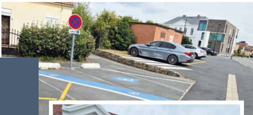
Le Pôle Social entièrement repeint
