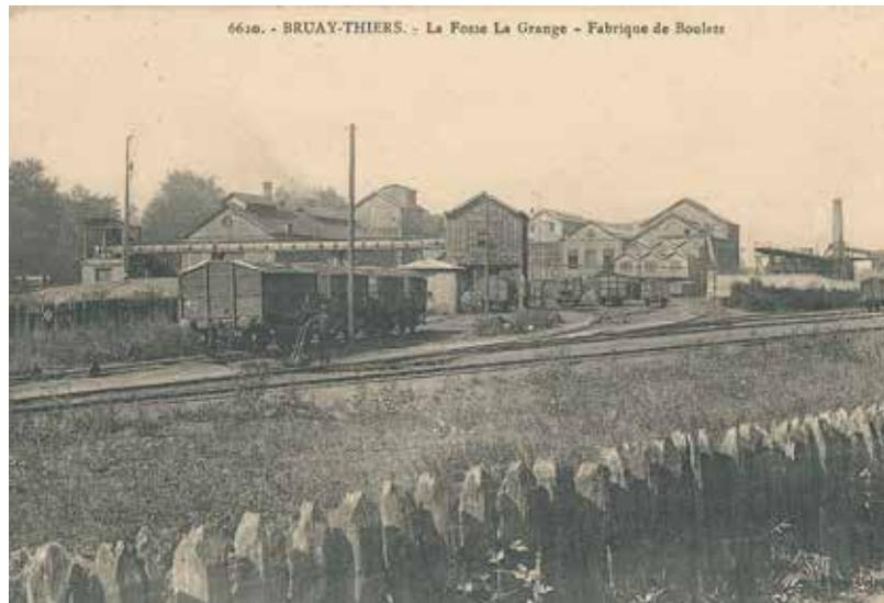
1930. Sur le carreau de la fosse, une usine d'agglomérés produit, outre des boulets, des briquettes très appréciées par la marine d'Etat et par les chemins de fer. (Une briquette : poids 10 kg, forme parallélépipédique, stockage et comptage faciles).
